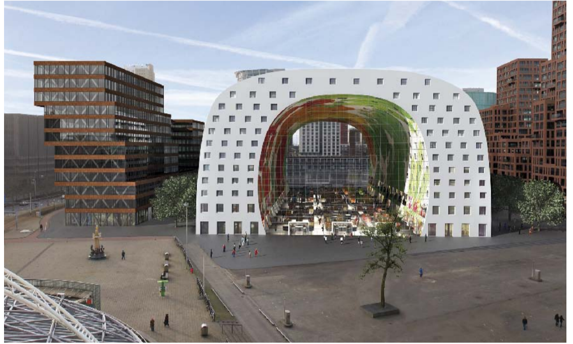
• Boogconstructie in tunnelbouw uitgevoerd.
