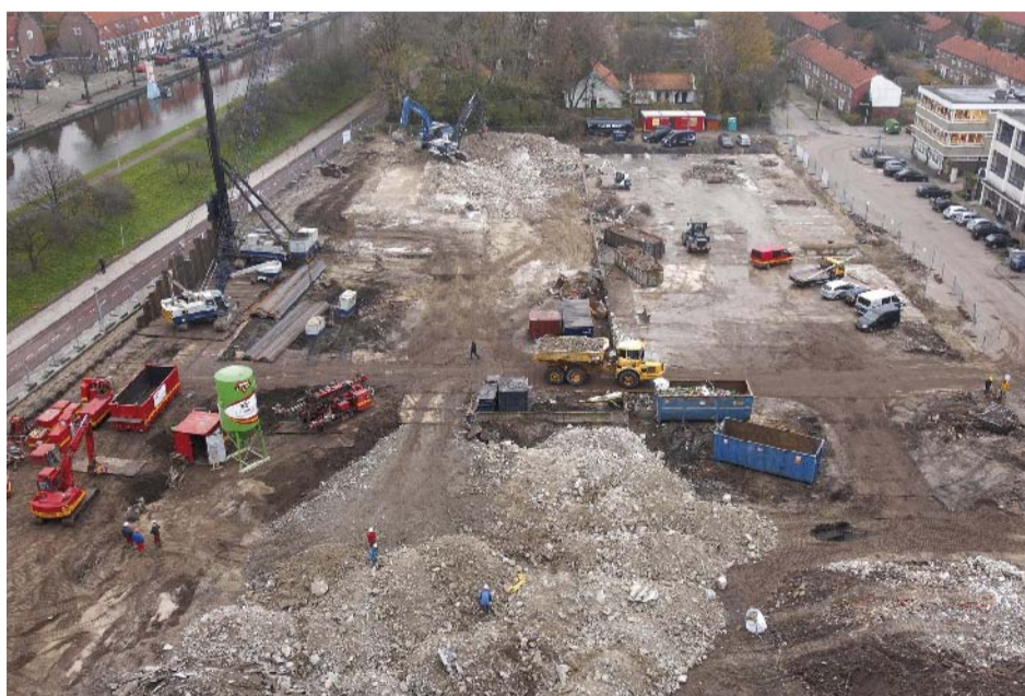
• De voormalige bebouwing op het Eenhoornterrein is volledig gesloopt.
